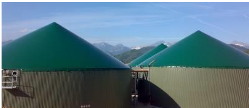
Impianto ambientale Zooagrobionergetico a ciclo chiuso – Vignolo – Cuneo – Potenza installata 1 MW
